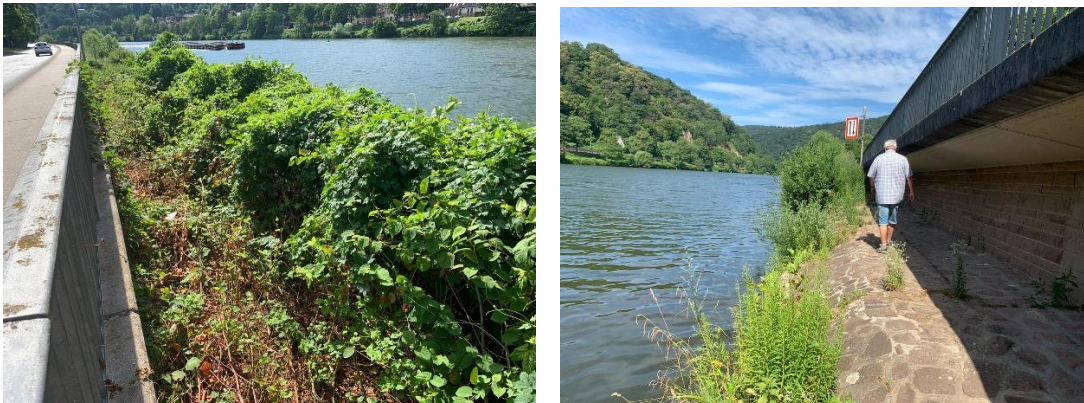
Bilder 5 und 6 – Gehwegüberbau von A nach G
